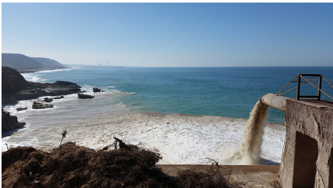
Déchets industriels de l'usine de phosphate de Safi jetés directement dans l'océan, décimant les poissons et la vie marine. A l'arrière-plan, on peut voir la centrale thermique au charbon nouvellement construite. Cliché pris en janvier 2016. Crédit photographique : Hamza Hamouchene.
